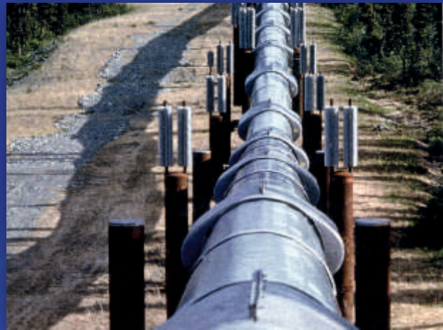
Монтаж трубопроводов на буроопускных сваях
