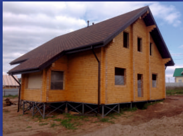
Монтаж деревянного дома
