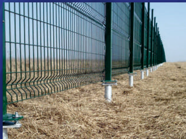
Монтаж ограждений на винтовых сваях
