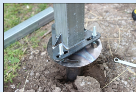
Стойка ограждения на винтовой свае
