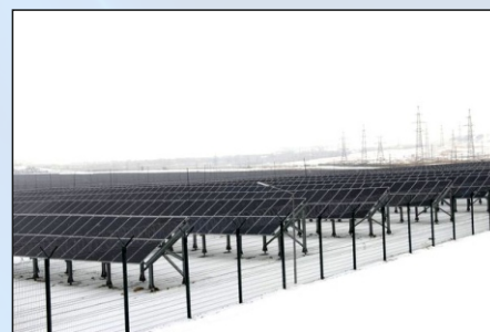
Солнечные батареи установленные на сваях производства ЮУЗВС «Егоза». Орская солнечная электростанция имени А. А. Влазнева
