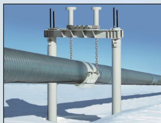
Трубопроводы на буроопускных сваях
