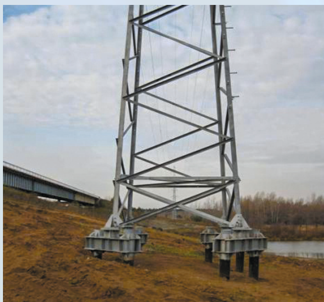
Варианты смонтированных ЛЭП на сваях и ростверках Южно-Уральского завода винтовых свай.
