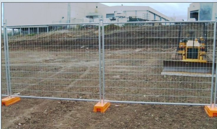
Временное ограждение строительной площадки
