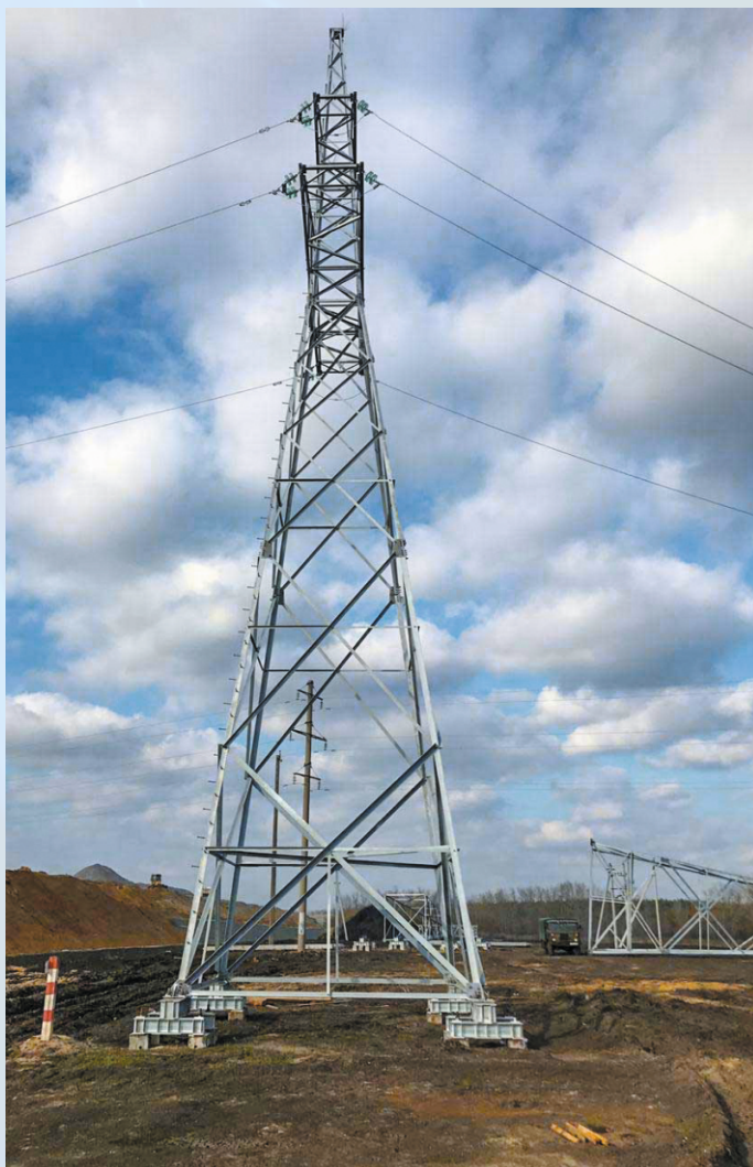
Варианты смонтированных ЛЭП на сваях и ростверках Южно-Уральского завода винтовых свай.
